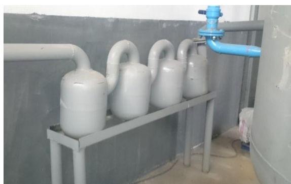
Слика Поглед на системот за ладење и контрола на емисии во воздух, лево садови со вода, десно садови за собирање на некондензибилни материи
