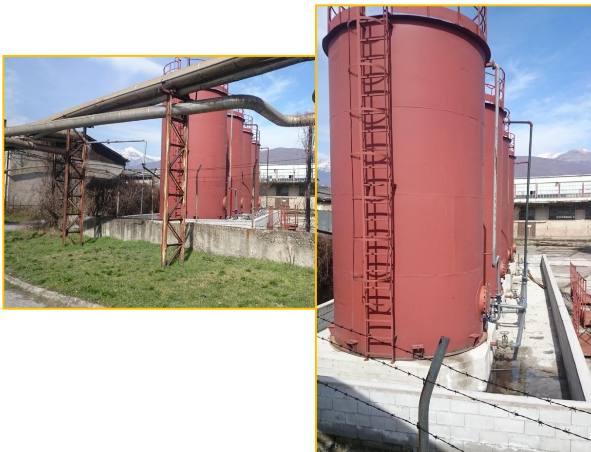
Слика – танквани на резервоари за отпадно масло
