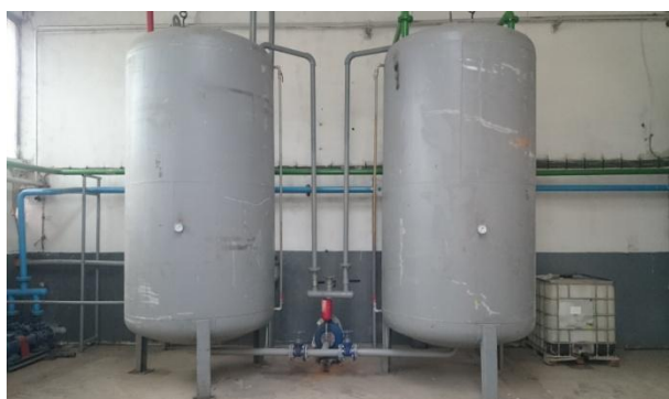
Слика Поглед на системот за ладење и контрола на емисии во воздух, лево садови со вода, десно садови за собирање на некондензибилни материи
